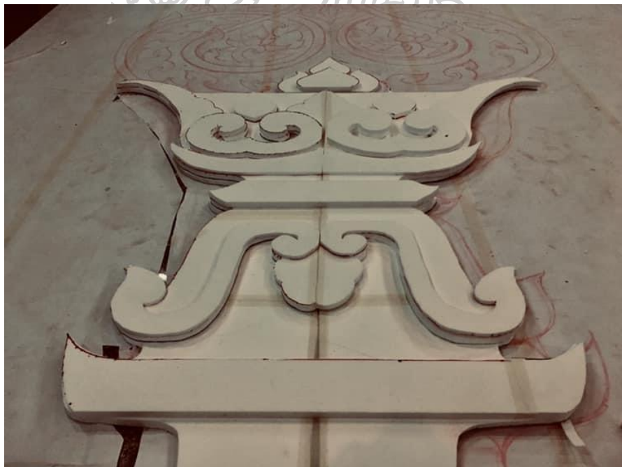
ภาพที่ 74 แบบหุ่นโฝมขนาด 1:1 ต้นแบบส่วนประดับเรือนธาตุที่สร้างขึ้นใหม่ (ส่วนชั้นหมากเบ็ง) ที่มา:ภาพถ่ายโดย พระทรงวิทย์ แจ้งจิตร เมื่อ พ.ศ.2562
