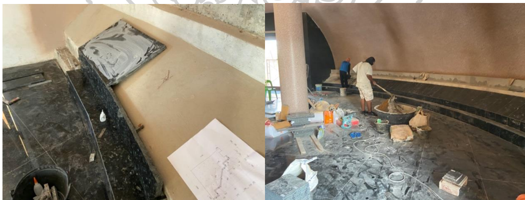
ภาพที่ 150 ขั้นตอนการประกอบติดตั้งบัวผนังภายใน (ซ้าย) ขณะการประกอบติดตั้งบัวผนังภายใน (ขวา)
