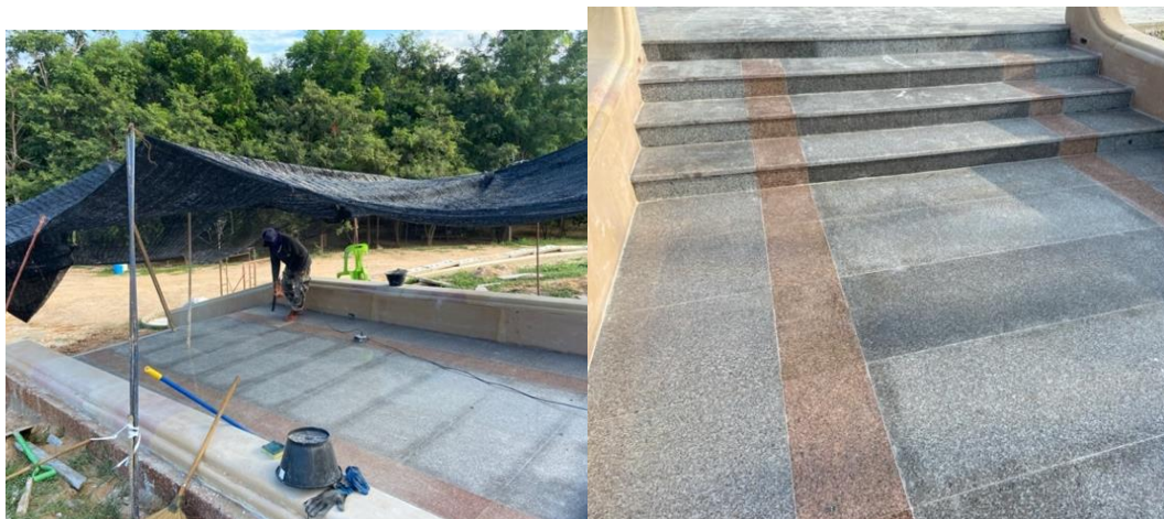
ภาพที่ 149 การปูพื้นบันไดทางขึ้น (ซ้าย) บันไดทางขึ้นในขณะทีแล้วเสร็จ (ขวา) ที่มา : ภาพถ่าย โดย พระทรงวิทย์ แจ้งจิตร ปี พ.ศ. 2563
