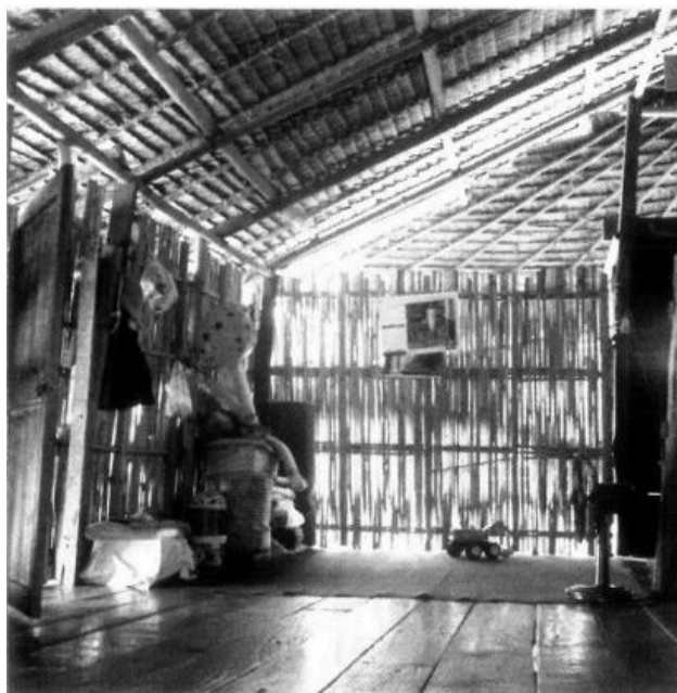
ภาพที่ 50 แสดงบรรยากาศภายในเรือนเครื่องผูกกิ่งเครื่องสับ ในส่วนที่ผนังเป็นฝาขัดแตะ ที่มา : วีระ อินพันทัง (2544)
