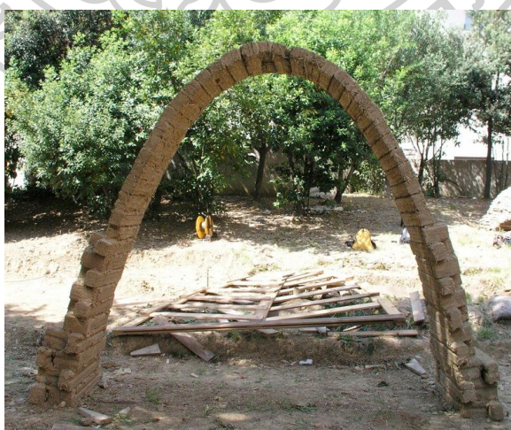
ภาพที่ 187 การนำลักษณะของเส้นโค้งแบบทิ้งน้ำหนัก (catenary curve) มากลับหัวและปรับใช้เป็น catenary arch ที่มีการถ่ายแรงอย่างสมดุลตามธรรมชาติของเส้นโค้งลักษณะนี้
