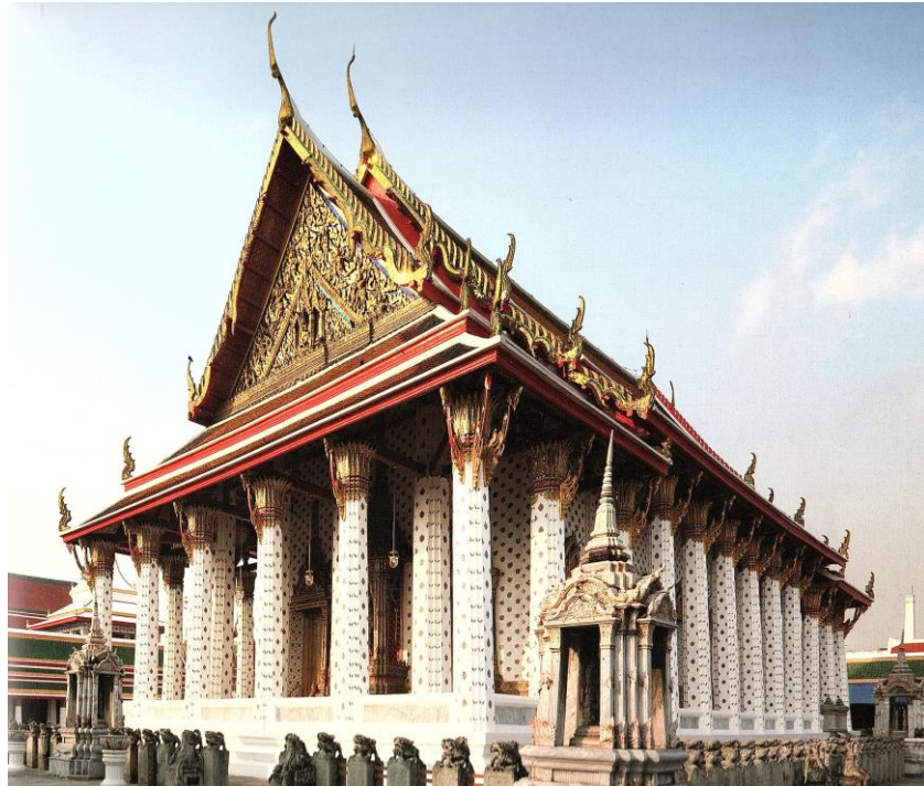
ภาพที่ 169 พระอุโบสถ วัดอรุณราชวรารามประดับพื้นผิวภายนอกด้วยเครื่องกระเบื้องอาศัยกระบวน ลายดอกพุดตานใบเทศประดับตกแต่งทำนองดอกไม้ร่วง ที่มา : ศานติ ภัคดีคำ (2557)
