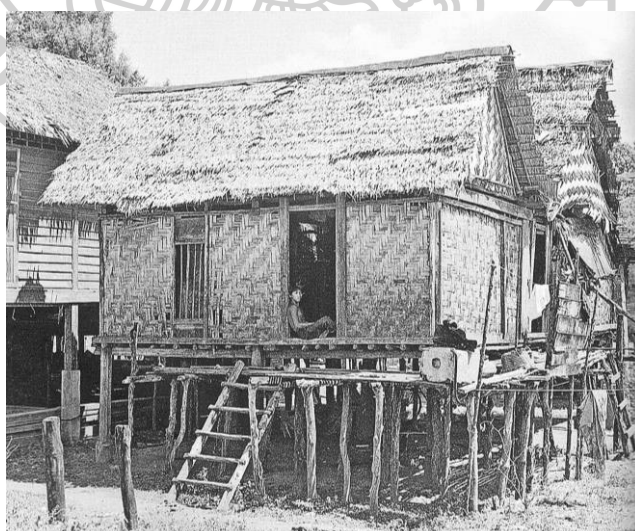
ภาพที่ 79 เรือนมุงฝาสานแบบเสื่อลำแพนที่เจ๊ะปลั่ง ในภาคใต้ ที่มา : น.ณ.ปากน้ำ (2555)
