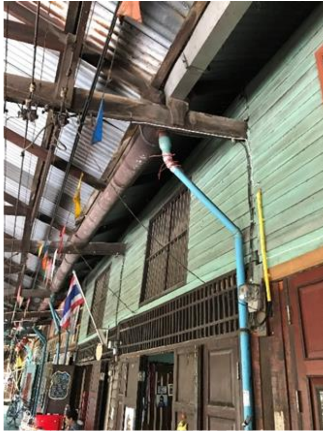
ภาพที่ 48 คานฝากของโครงสร้างหลังคาตลาดริมน้ำ ที่มา : ผู้วิจัย
