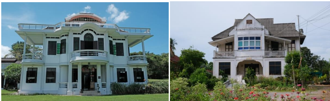
รูปที่ 20 บ้านบังกะโลแบบอาร์ตเดโคในหัวเมืองใต้ฝั่งตะวันตก ที่มา: โดยผู้วิจัย
