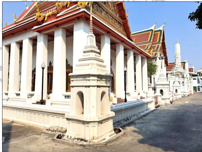
ภาพที่ 200 ภาพกำแพงแก้วและซุ้มเสมาจากมุมมองทางด้านทิศตะวันตกเฉียงใต้ของพระอุโบสถ
