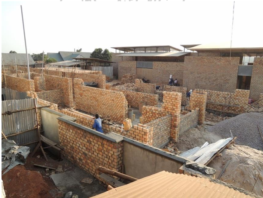
ภาพที่ 89: การออกแบบโดยใช้ผนังสองชั้น ปรากฏในกรณีศึกษา AU Dormitory
