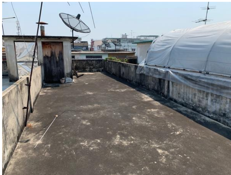
ภาพที่ 193: ลักษณะการใช้พื้นที่ชั้นดาดฟ้า กรณีศึกษาอาคารตึกแถวที่ 3
