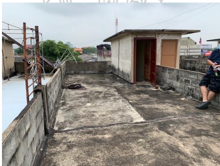
ภาพที่ 185: ลักษณะการใช้พื้นที่ชั้นดาดฟ้า กรณีศึกษาอาคารตึกแถวที่ 2 ที่มา: ผู้วิจัย
