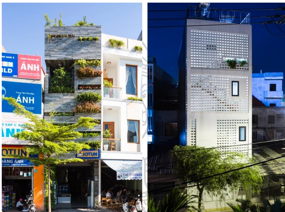
ภาพที่ 35: ทศนิยมภาพอาคาร Garden House ที่มา: (Cabrera, 2017; Oki, 2016)
