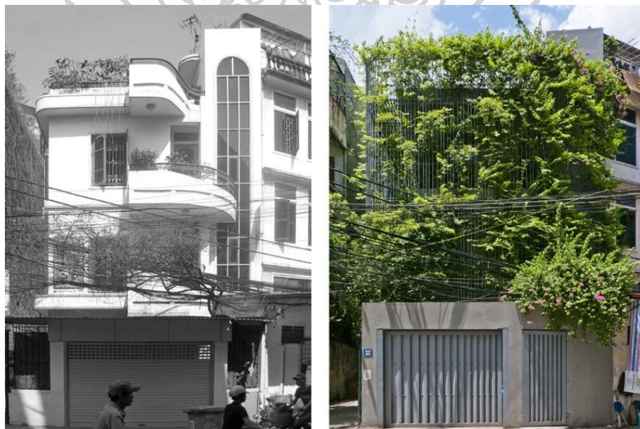
ภาพที่ 26: ทัดนียภาพอาคาร Green Renovation ก่อนและหลังการปรับปรุง
