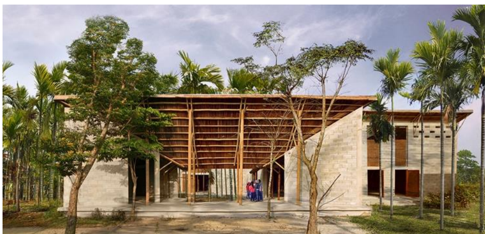
ภาพที่ 20: ทัศนียภาพอาคาร Cam Thanh Community House
