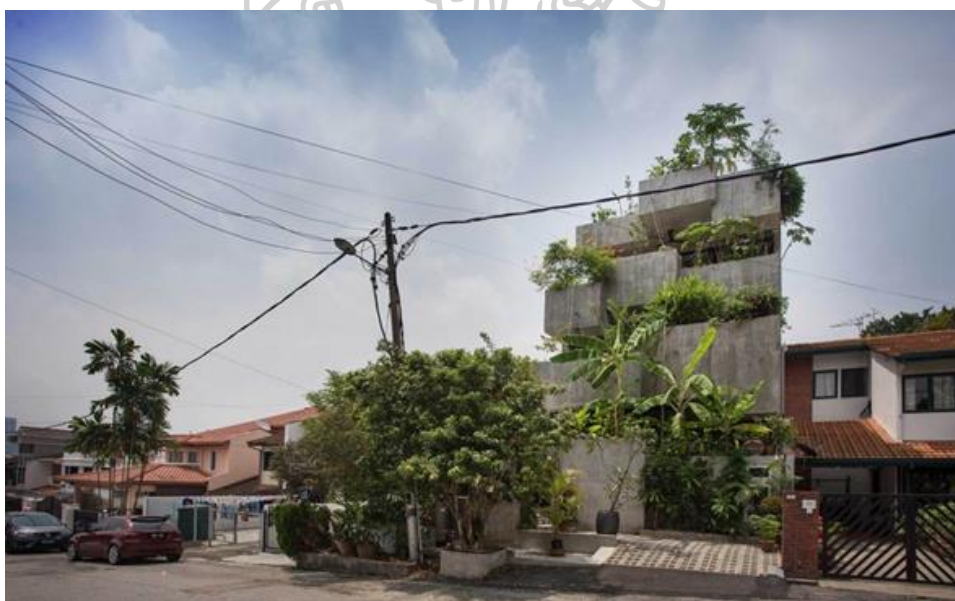
ภาพที่ 23: ทศนิยมภาพอาคาร Planter Box House
