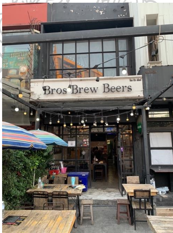
ภาพที่ 172: ลักษณะอาคาร กรณีศึกษาอาคารตึกแถวที่ 1
