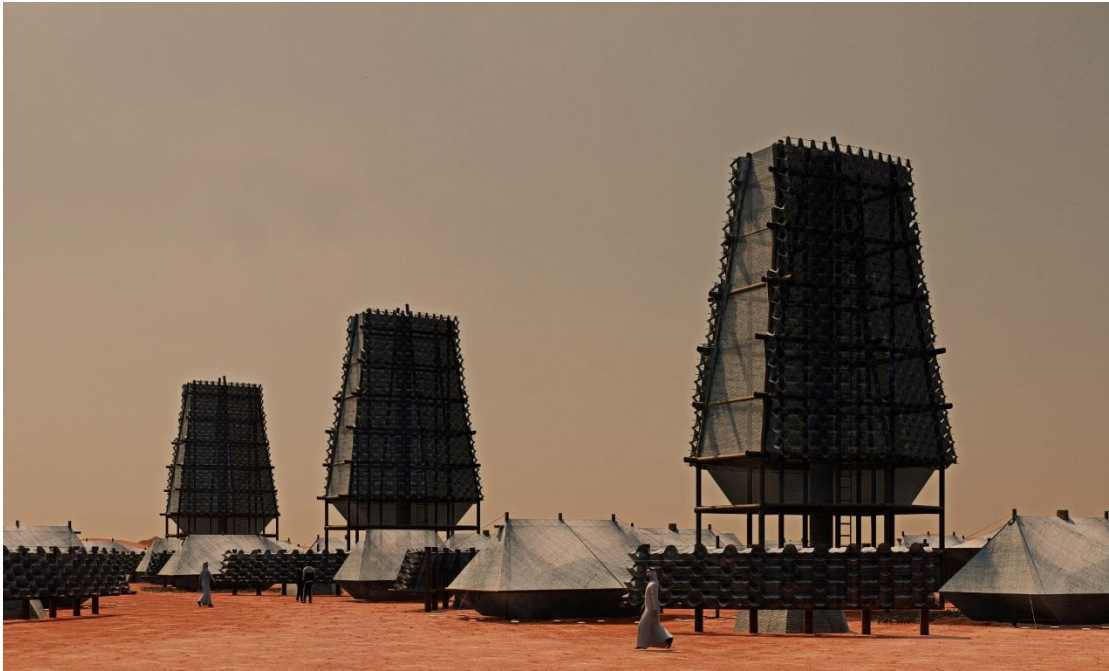
ภาพที่ 71 แสดงทัศนียภาพในบริเวณกลุ่มอาคาร สังเกตได้ว่าในบริเวณชั้นนอกของกลุ่มอาคารมีการติดตั้งแผงดักจับน้ำจากอากาศเพิ่มเติมเพื่อเพิ่ม ประสิทธิภาพในการผลิตน้ำและความชื้น (จากการศึกษาของผู้วิจัย)
