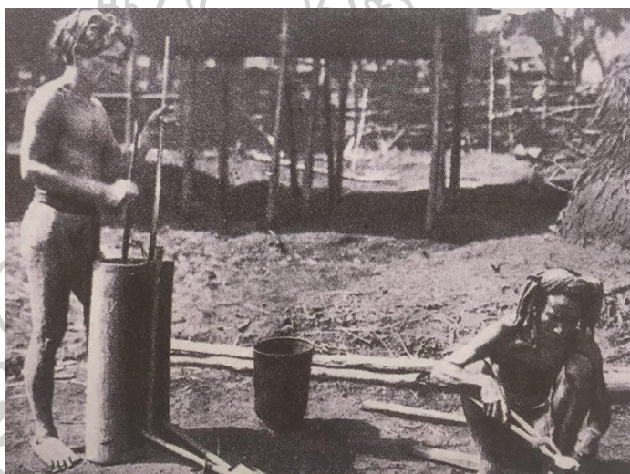
ภาพที่ 108 ระบบสูบลมแบบสองลูกสูบ (Double piston bellow)
