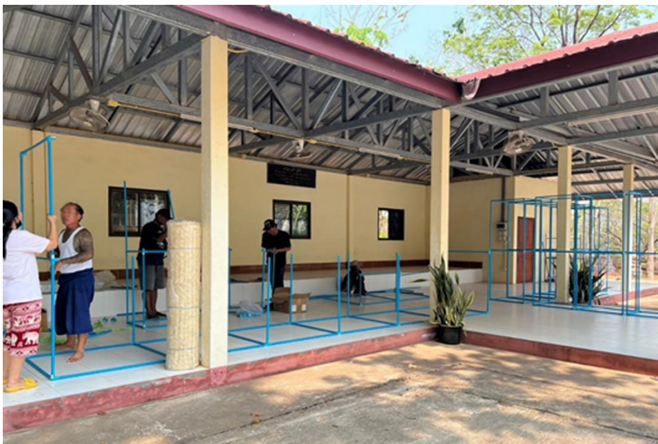
ภาพที่ 88 การเตรียมพื้นที่โครงการเปลี่ยน ปรับ ปรก ในพื้นที่วัดตาลใหญ่ ที่มา: ผู้วิจัย, 2566
