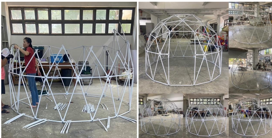
รูปภาพที่ 67 ภาพขั้นตอนการสร้างสรรค์ผลงานชุดที่ 1 (ขึ้นโครงสร้างโดม)
