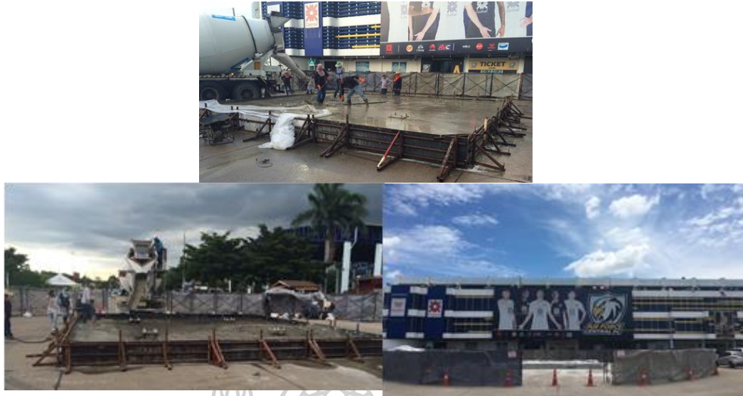
ภาพที่ 61 แสดงงานก่อสร้างฐานราก และโครงสร้างพื้น
