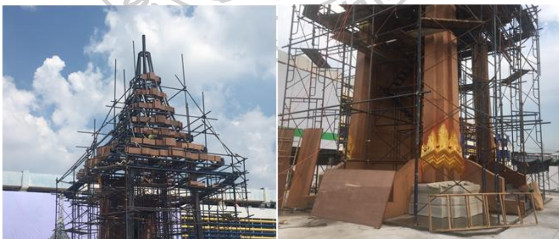
ภาพที่ 66 แสดงงานติดตั้งกรุผิวไม้อัดโดยรอบและงานบุชบก
