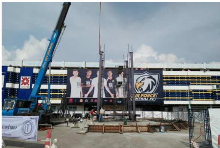
ภาพที่ 63 แสดงงานติดตั้งโครงสร้างเหล็กเสา
