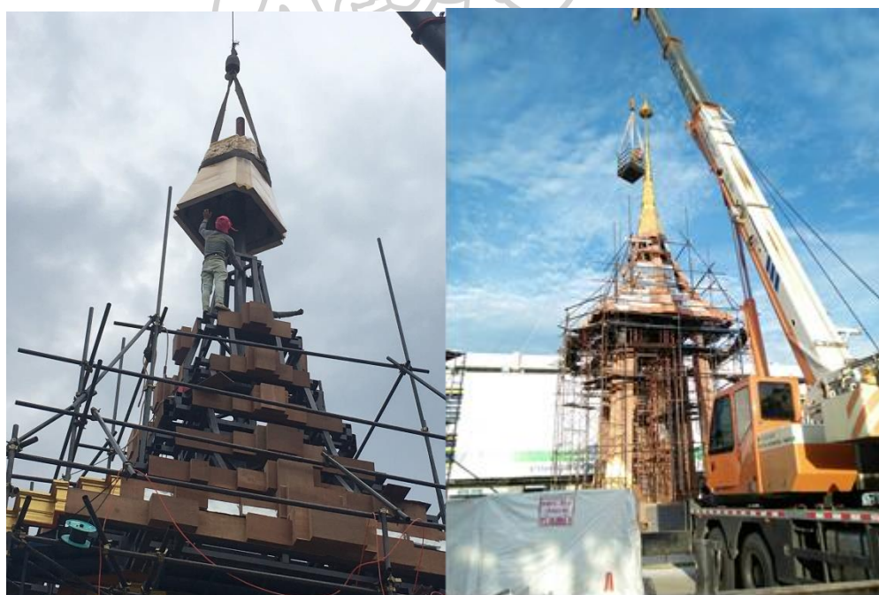
ภาพที่ 69 แสดงงานยกประกอบติดตั้งบุชบส่วนบน
