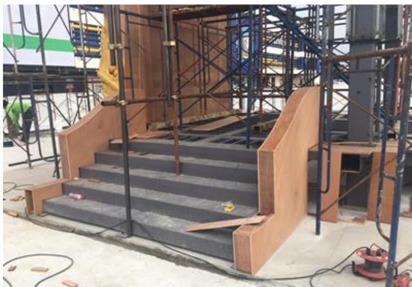
ภาพที่ 65 แสดงงานติดตั้งกรุผิวไม้อัด
