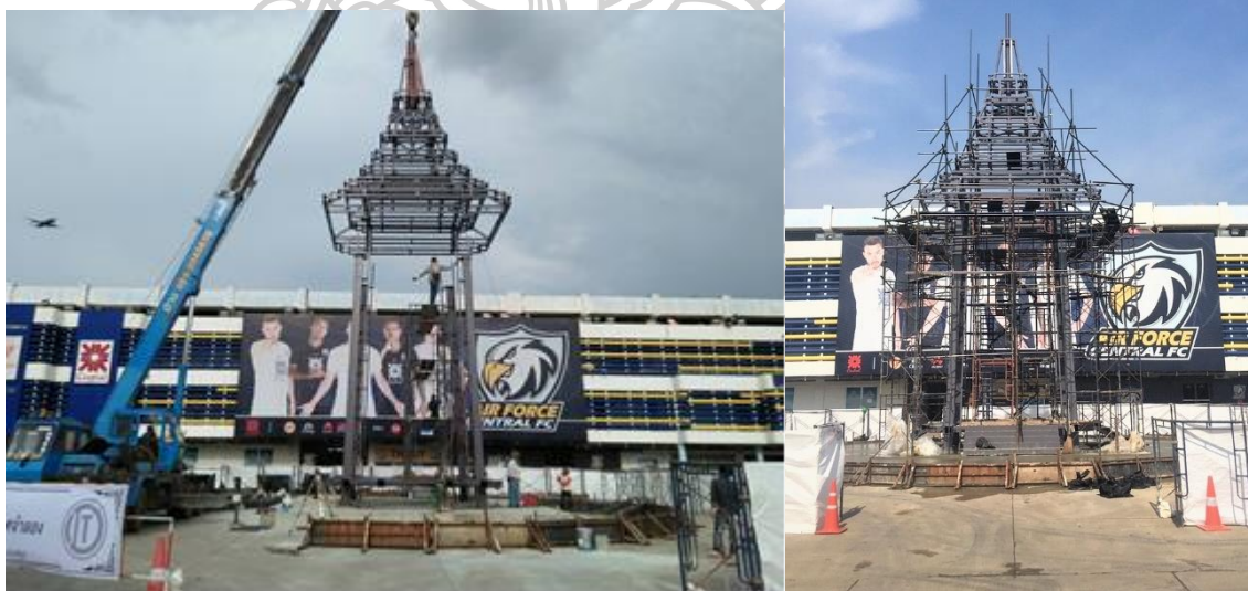
ภาพที่ 64 แสดงงานติดตั้งโครงสร้างเหล็กประกอบเป็นทรงหลังคาบุษบกสำเร็จ 7 ชั้น
