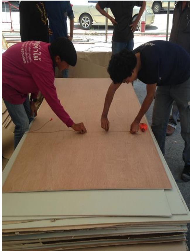
ภาพที่ 78 ขั้นตอนที่ 3 งาน กรูผิวไม้อัด
