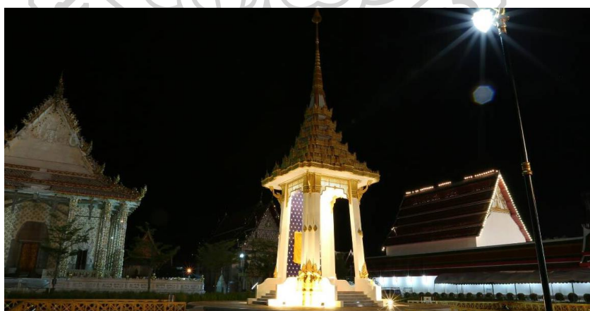
ภาพที่ 5 ภาพ พระเมรุมาศจำลองจังหวัดสุพรรณบุรี ก่อสร้างแล้วเสร็จ (ที่มา กองควบคุมงานก่อสร้าง (2560) กรมโยธาธิการและผังเมือง)
