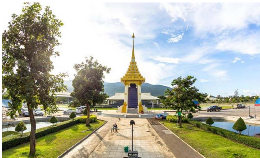
ภาพที่ 14 ภาพพระเมรุมาศจำลอง ก่อสร้างแล้วเสร็จ (ที่มา : กองควบคุมงานก่อสร้าง ,2560, กรมโยธาธิการและผังเมือง)
