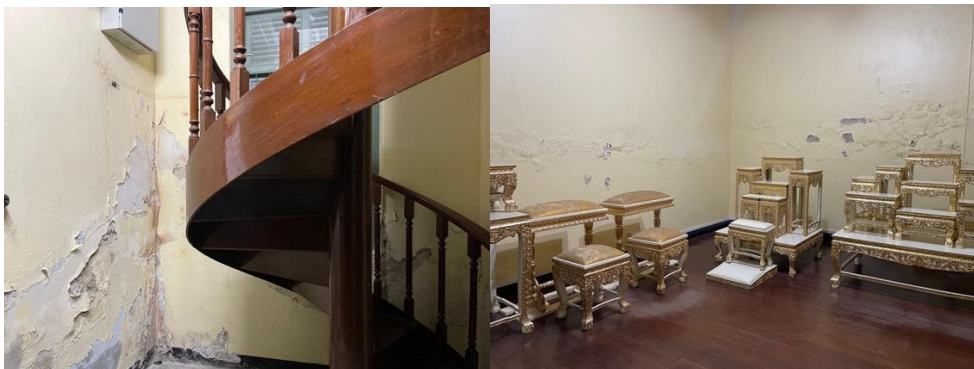
ภาพที่ 5.6 สภาพความเสียหายจากความชื้น และการใช้งานเป็นห้องเก็บของเหลือใช้สำนักงาน ที่มา: ชนะภพ วัฒนโอฬาร ถ่ายเมื่อ 10 มิถุนายน 2564
