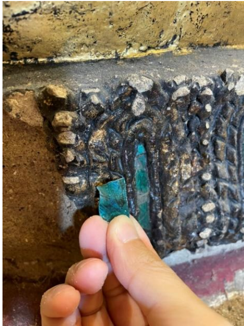
ภาพที่ 57 การเปรียบเทียบสีกระจกเกรียบที่ผู้วิจัยผลิตขึ้นมาใหม่ กับกระจกเกรียบสีเขียวประดับฐานชุกชีพระประธานในพระอุโบสถ
