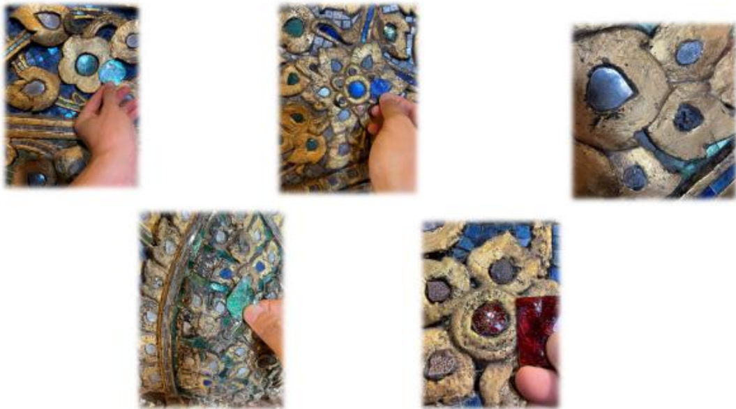
ภาพที่ 70 การนำกระจกกรียบที่ผลิตขึ้นมาใหม่ เปรียบเทียบความกลมกลืนทางกายภาพด้านสี และเนื้อ กับกระจกกรียบของเก่าที่ประดับลวดลายปูนปั้นพระเขนยพระพุทธไสยาส วัดพระเชตุพนวิมลมังคลาราม
