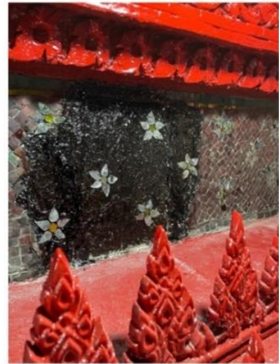
ภาพที่ 105 การเตรียมกระจกเกรียบที่ประดิษฐ์ขึ้นโดยตัดให้มีขนาดและรูปทรงตามลวดลายเดิมเตรียมไว้เพื่อการบูรณะ
