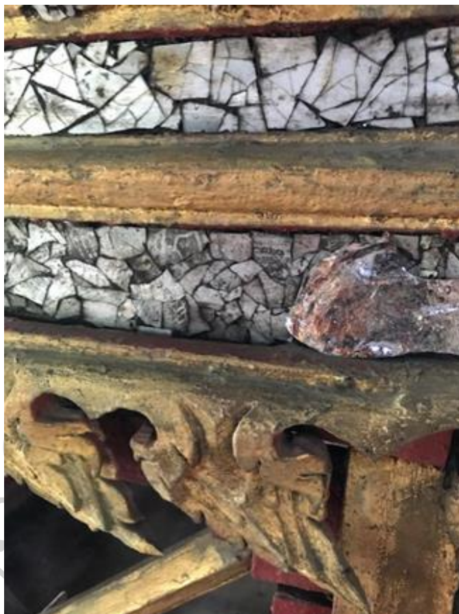
ภาพที่ 84 การใช้กระจกแก้วสีขาว (ทำเก่าเพื่อการบูรณะ) เปรียบเทียบกับกระจกเกี๋ยบบที่ผลิตขึ้นใหม่ ด้วยวิธีอย่างโบราณ บริเวณท้องไม้ฐานของธรรมาสน์ยาว วัดเชิงท่า
