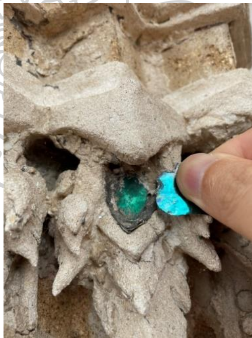
ภาพที่ 58 การเปรียบเทียบสีกระจกเกรียบที่ผู้วิจัยผลิตขึ้นมาใหม่ กับกระจกเกรียบสีเขียวประดับซุ้มประตูพระอุโบสถ วัดปราสาท
