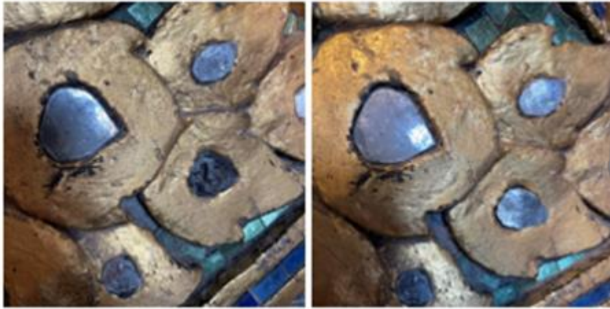
ภาพที่ 71 การนำกระจกสีเขียวที่ประดิษฐ์ขึ้นใหม่มาทดลองประดับจริงที่ลวดลายปูนปั้นประดับพระเขนยพระพุทธไสยาส วัดพระเชตุพนวิมลมังคลาราม
