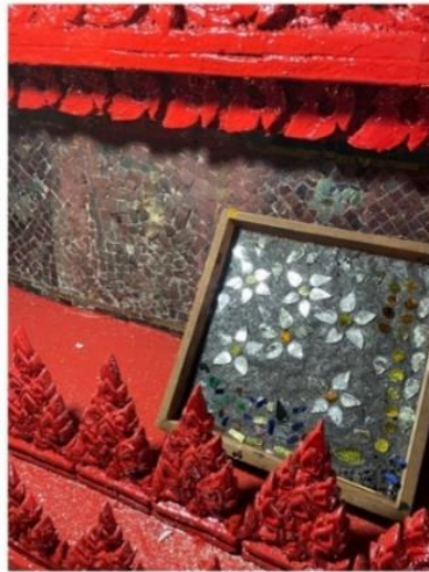
ภาพที่ 105 การเตรียมกระจกเกรียบที่ประดิษฐ์ขึ้นโดยตัดให้มีขนาดและรูปทรงตามลวดลายเดิมเตรียมไว้เพื่อการบูรณะ
