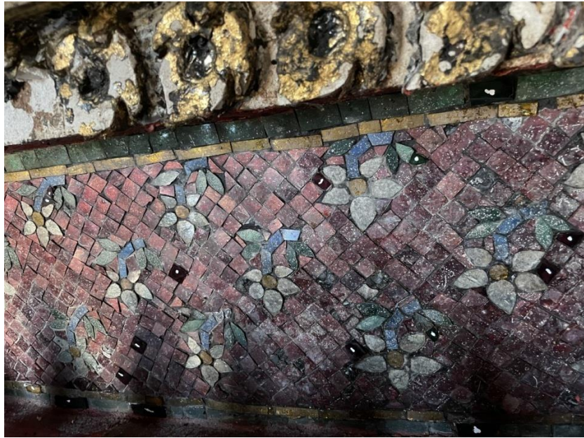
ภาพที่ 96 ความขุ่นมัวของผิวหน้ากระจกเนื่องจากกาลเวลา
