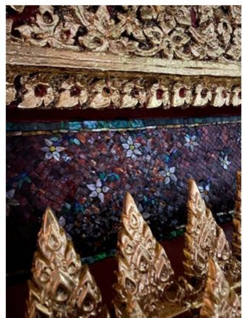
ภาพที่ 106 การติดกระจกโดยให้ความสำคัญกับลวดลายการประดับรูปแบบดั้งเดิมและเลือกสีกระจกให้กลมกลืนกับกระจกเกรียบของเก่า
