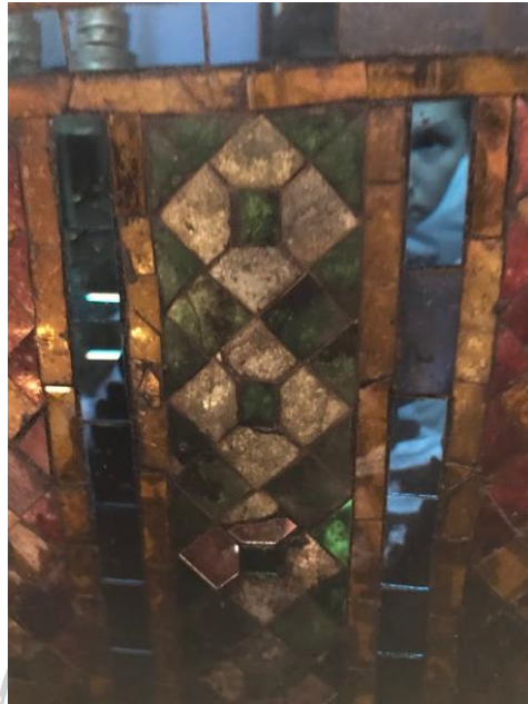
ภาพที่ 24 กระจกแก้วสมัยใหม่ ในการบูรณะปะปนกับกระจกเกريبโบราณ
