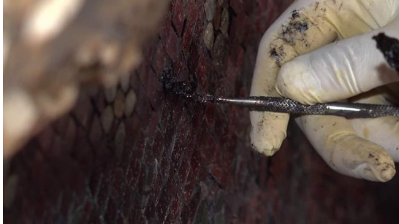
ภาพที่ 103 การใช้เทือกรัก (รักสมุก) เป็นวัสดุยึดติดกระจกเกரியบ
