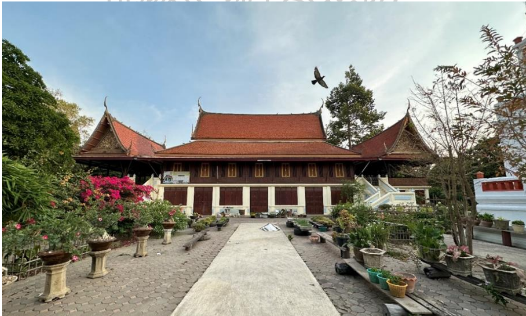
ภาพที่ 17 ศาลาการเปรียญวัดยาง (ภาพถ่ายจากการลงพื้นที่สำรวจข้อมูล โดย เขมา แฉ่งฉายา, พฤษภาคม 2565.)
