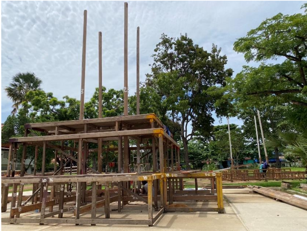
ภาพที่ 27 การทดลองประกอบเมรุ โดยช่างยุคปัจจุบันของวัดใหญ่สุวรรณาราม (จากการลงพื้นที่สำรวจข้อมูลการทดลองประกอบเมรุ โดยช่างยุคปัจจุบันของวัดใหญ่สุวรรณาราม ภาพถ่ายโดย เขมา แฉ่งฉายา, พฤษภาคม 2566.)
