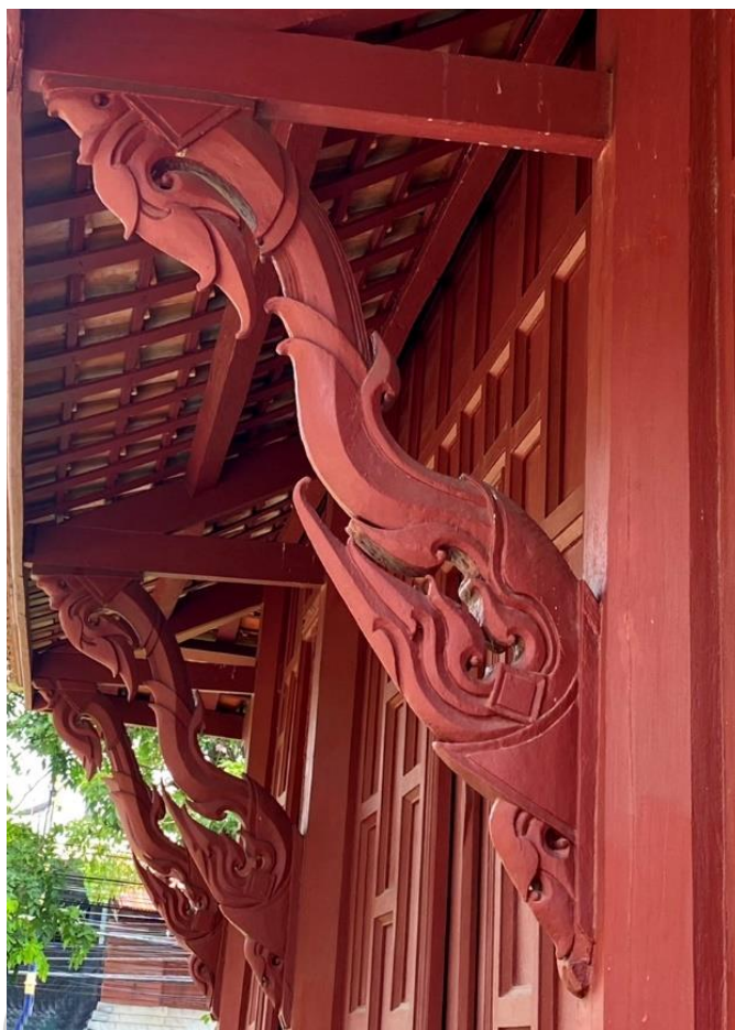
ภาพที่ 13 “คันทวยหน้าตักแดน” ส่วนประกอบที่สำคัญ ศาลาการเปรียญ วัดใหญ่สุวรรณาราม (ภาพถ่ายจากการลงพื้นที่สำรวจข้อมูล โดย เขมา แฉ่งฉายา, พฤษภาคม 2565.)
