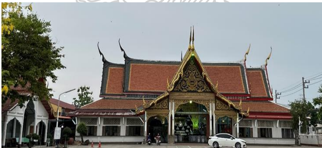
ภาพที่ 45 อาคารศาลาบำเพ็ญกุศล วัดยาง (ภาพถ่ายจากการลงพื้นที่สำรวจข้อมูล โดย เขมา แฉ่งฉายา, มีนาคม 2566.)
