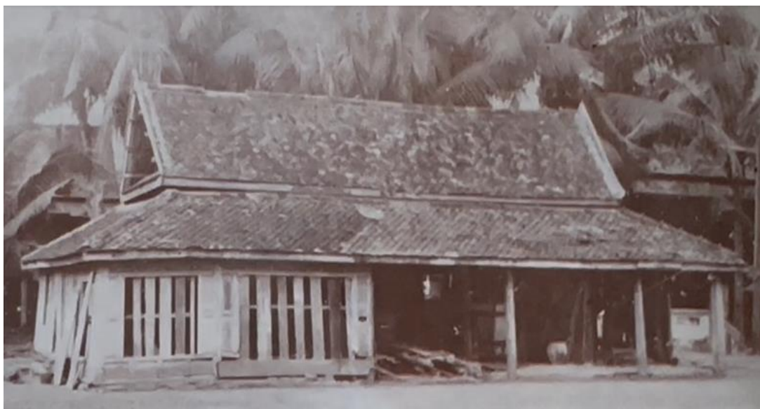
ภาพที่ 66 อาคารเดิม โรงเรียนช่างไม้วัดยาง
