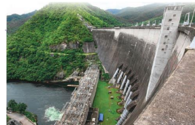
▲ เขื่อนภูมิพล จังหวัดตาก สร้างปิดกั้นแม่น้ำปิง เพื่อบริหารจัดการน้ำและผลิตกระแสไฟฟ้า มีลักษณะเป็นเขื่อนคอนกรีตขนาดใหญ่
