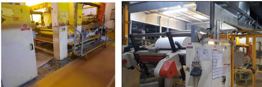
รูปที่ 3.9 ก่อนการปรับปรุงพื้นที่บริเวณเครื่องชุบกระดาษ
