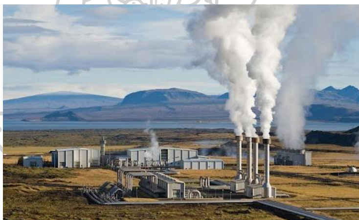
ภาพที่ 15 โรงไฟฟ้าพลังความร้อนใต้พิภพ [13]
