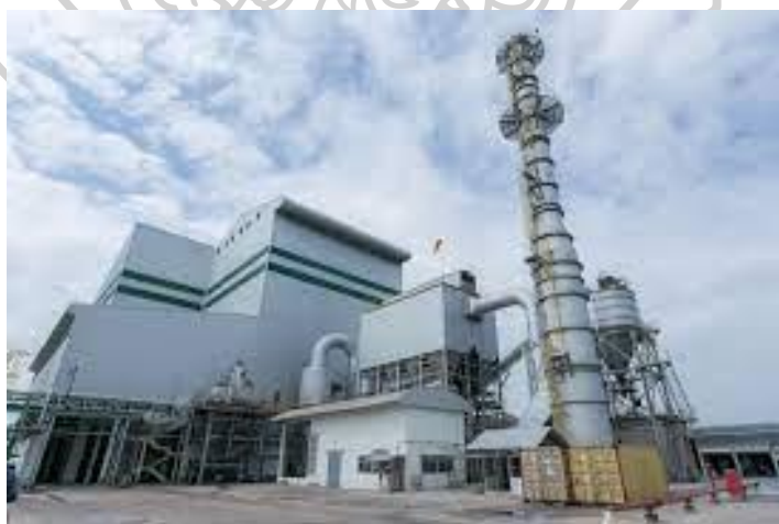
ภาพที่ 14 โรงไฟฟ้าขยะ [12]
