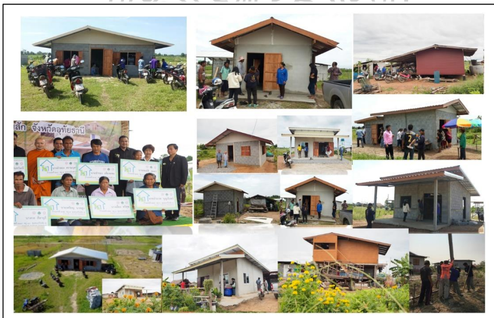
ภาพที่ 77 บ้านในชุมชนที่ดำเนินการปรับปรุงซ่อมแซม และสร้างใหม่ ที่มา : สถาบันพัฒนาองค์กรชุมชน (องค์การมหาชน), (2560)
