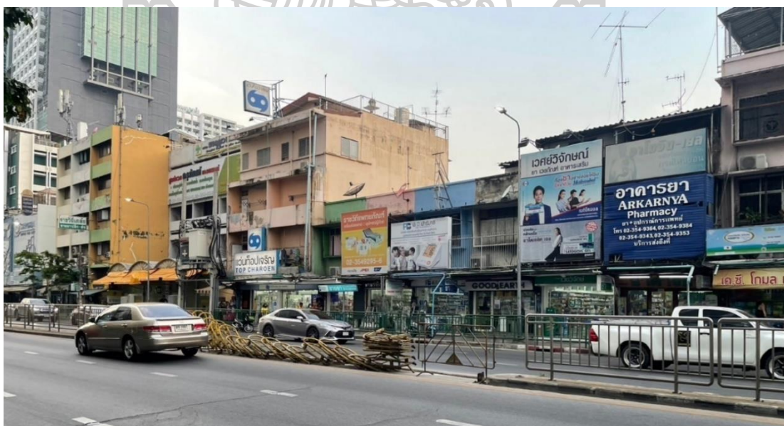
ภาพที่ 58 อาคารพาณิชย์กรรมเฉพาะทางด้านการแพทย์ บริเวณถนนราชวิถีฝั่งโรงพยาบาลพระมงกุฎฯ ผู้วิจัย, 2567
