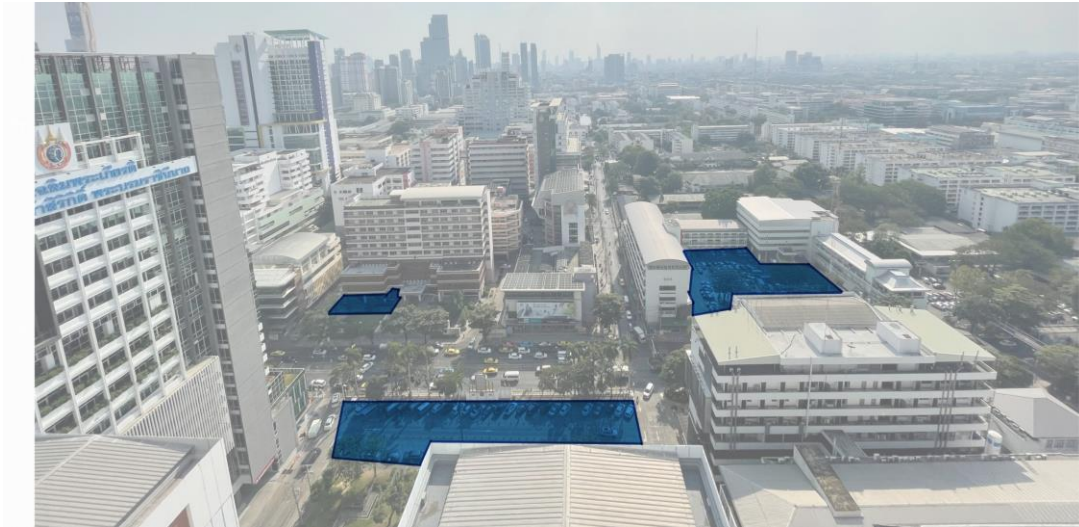
ภาพที่ 29 พื้นที่จอดรถของภาครัฐ
