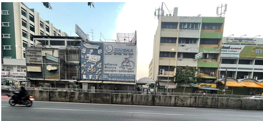
ภาพที่ 57 อาคารพาณิชย์กรรมบริเวณถนนราชวิถีฝั่งโรงพยาบาลพระมงกุฎฯ ผู้วิจัย, 2567
