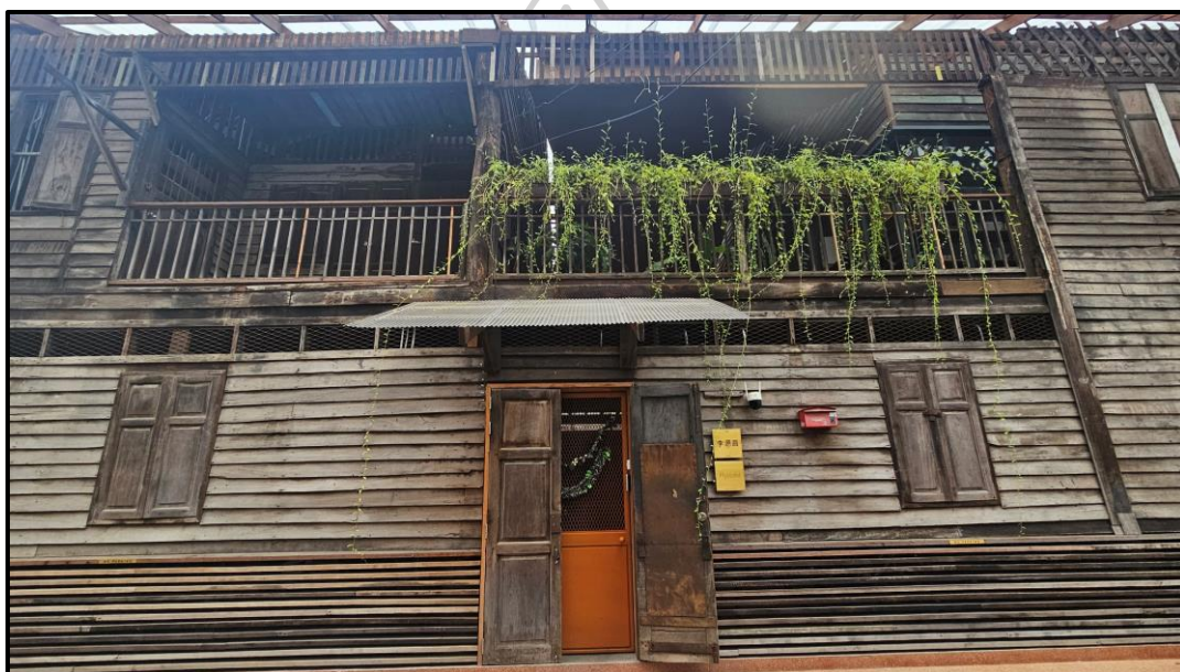
ภาพที่ 32 อาคารไม้บริเวณซอยศาลเจ้าโจวซือกง (ที่มา : ผู้วิจัย, 2566)
