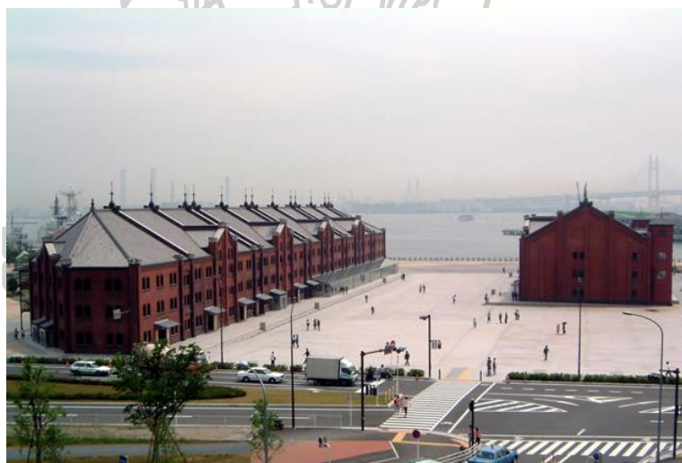
ภาพที่ 34 อาคารและลานกิจกรรม Yokohama Red Brick Warehouse
