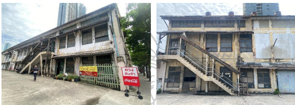
ภาพที่ 65 ภายนอกอาคารโรงงาน
