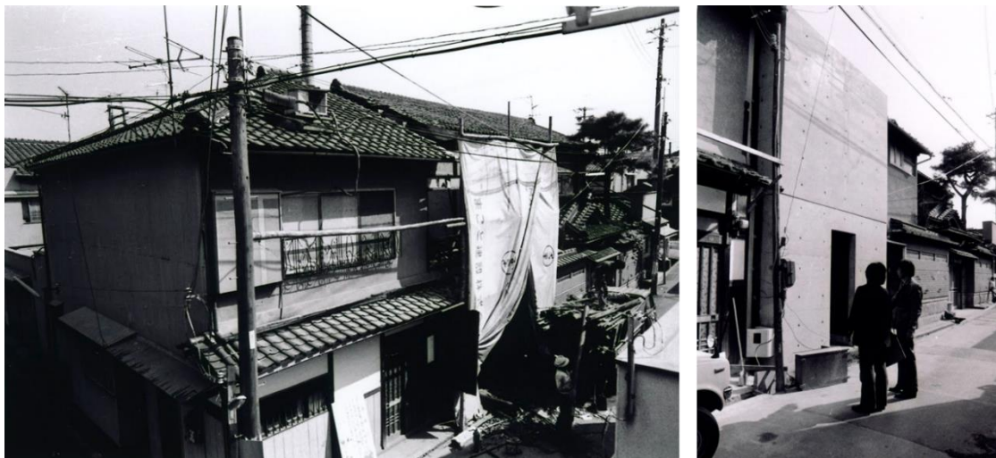
ภาพที่ 102 บ้านอะซุมาะ ระหว่างการก่อสร้างและปรับท้างเคียง
