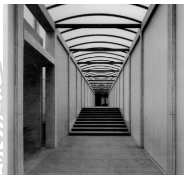
ภาพที่ 147 การใช้กระจกชั้นที่ปิดกั้นการมองเห็นภายนอกและบันไดเดินลง
