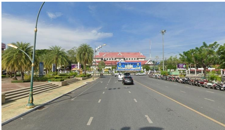
รูปที่ 5 : แสดงถนนสายหลัก ชื่อถนนสายบุรี ที่มา : ผู้วิจัย
