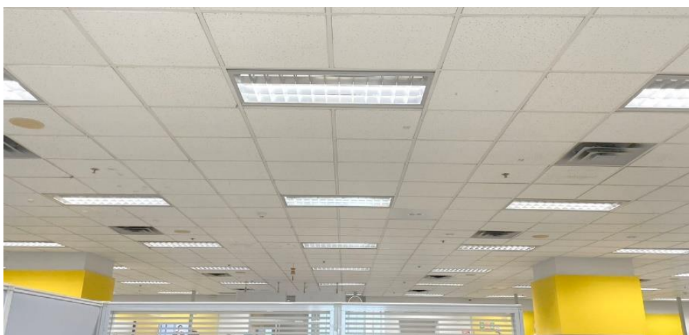
รูปที่ 34 แหล่งกำเนิดแสงสว่างปัจจุบันจากโคมตะแกรงฝังฝ้า หลอด Fluorescent T8 /54 36W DAYLIGHT, CRI > 80 จำนวน 2 หลอดต่อโคม ที่มา: ผู้วิจัย, 2566
