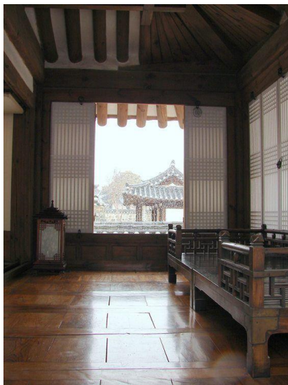
ภาพที่ 186 กระดาษข้าวที่ใช้ในสถาปัตยกรรมเกาหลีแบบดั้งเดิม
