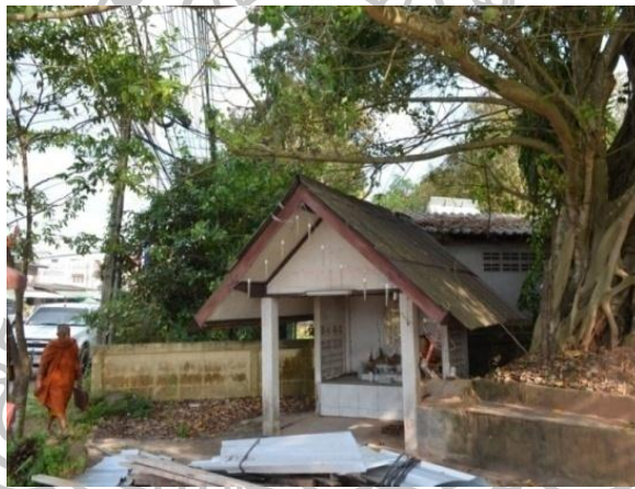
ฐานอาคารบริเวณศาลปะหมอ(ปัจจุบัน)
