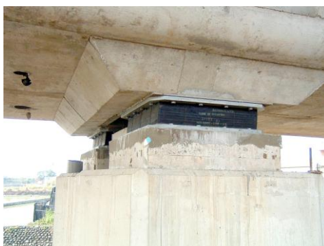
ภาพที่ 12 แสดงผลิตภัณฑ์ยางรองคอสะพาน ที่มา: PCP, PECON, เข้าถึงเมื่อ 13 มกราคม 2557, เข้าถึงได้จาก http://www.pcp-pecon.com/products/bearingpad
