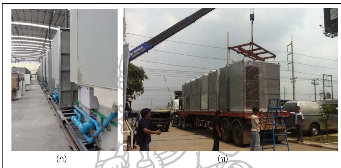
ภาพที่ 29 ห้องน้ำที่ขึ้นผนังด้วยระบบสำเร็จรูปและลักษณะการขนส่ง
