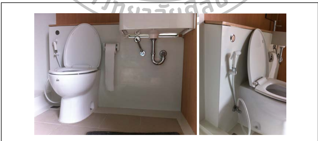
ภาพที่ 53 แสดงภาพงานต้นแบบ ผนังสำเร็จรูปที่ช้อนงานระบบ
