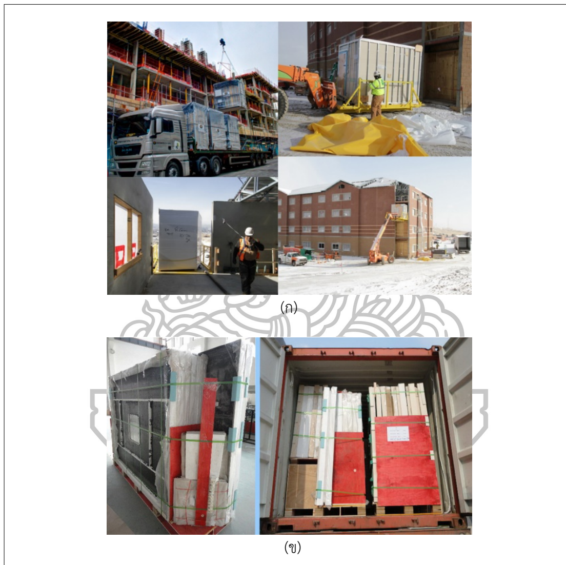
ภาพที่ 24 การประกอบติดตั้งห้องน้ำสำเร็จรูป
