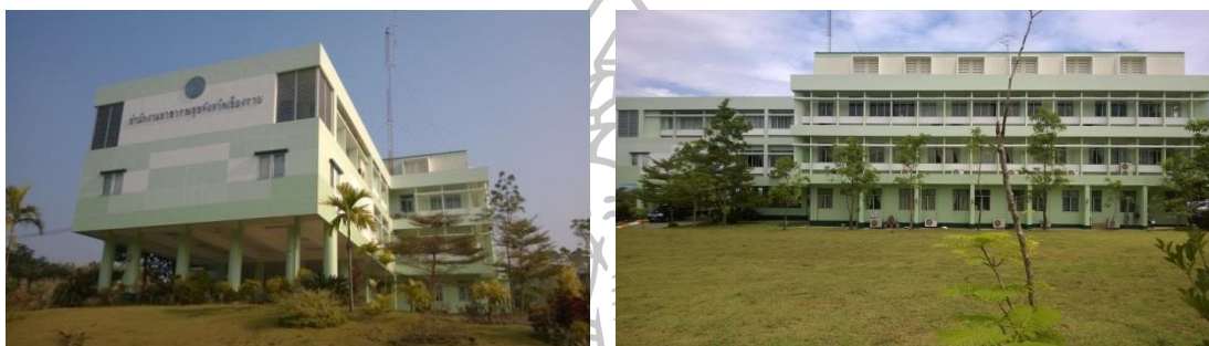
ภาพที่ 1 ลักษณะภายนอกของอาคารสำนักงานสาธารณสุขจังหวัดเชียงราย (ถ่ายโดยผู้วิจัย ณ สำนักงานสาธารณสุขจังหวัดเชียงราย อำเภอเมือง จังหวัดเชียงราย เมื่อมิถุนายน 2557)
