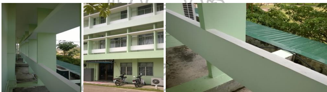
ภาพที่ 7 แผงบังแดดคอนกรีตภายนอกของอาคารสำนักงานสาธารณสุขจังหวัดเชียงราย (ถ่ายโดยผู้วิจัย ณ สำนักงานสาธารณสุขจังหวัดเชียงราย อำเภอเมือง จังหวัดเชียงราย เมื่อมิถุนายน 2557)
