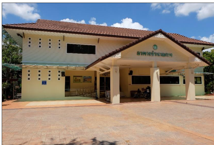
ภาพที่ 11 ภาพอาคารกองอำนวยการสถานสงเคราะห์เด็กอ่อนปากเกร็ด จังหวัดนนทบุรี
