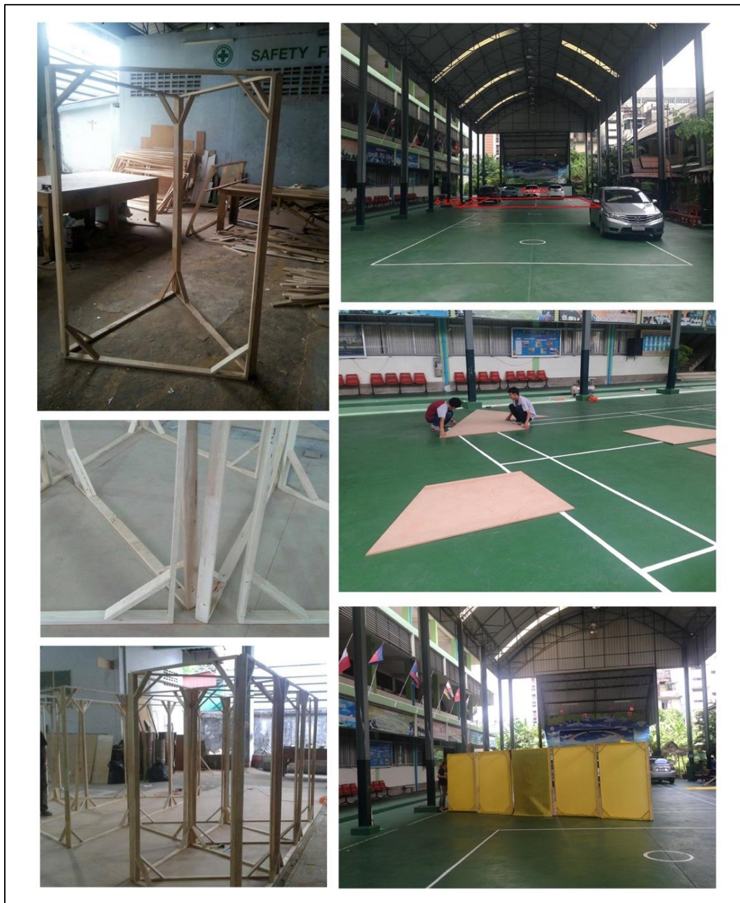
ภาพที่ 61 ระหว่างการติดตั้งพื้นที่จำลอง
