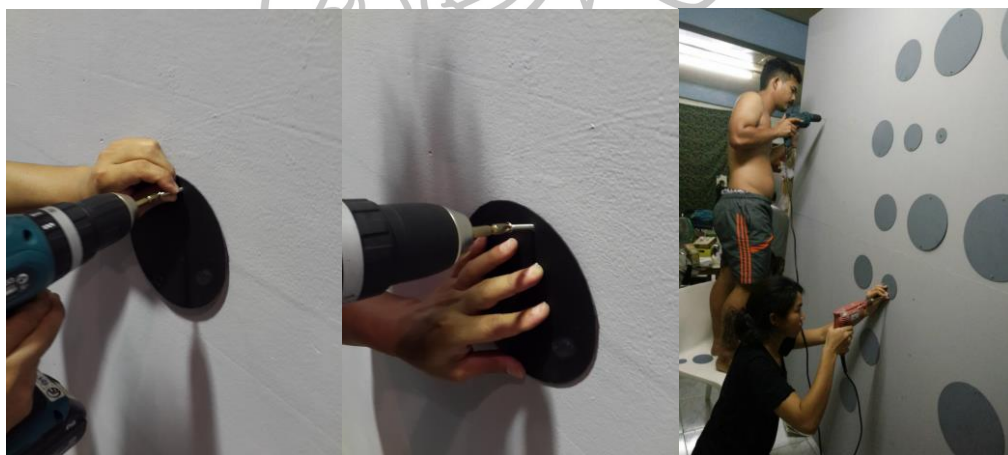
ภาพที่ 73 ภาพการติดแผ่นเหล็กกับแท่นผนัง ถ่ายเมื่อ 19 กรกฎาคม 2559, ถ่ายโดยผู้สร้างสรรค์ ผลงาน
