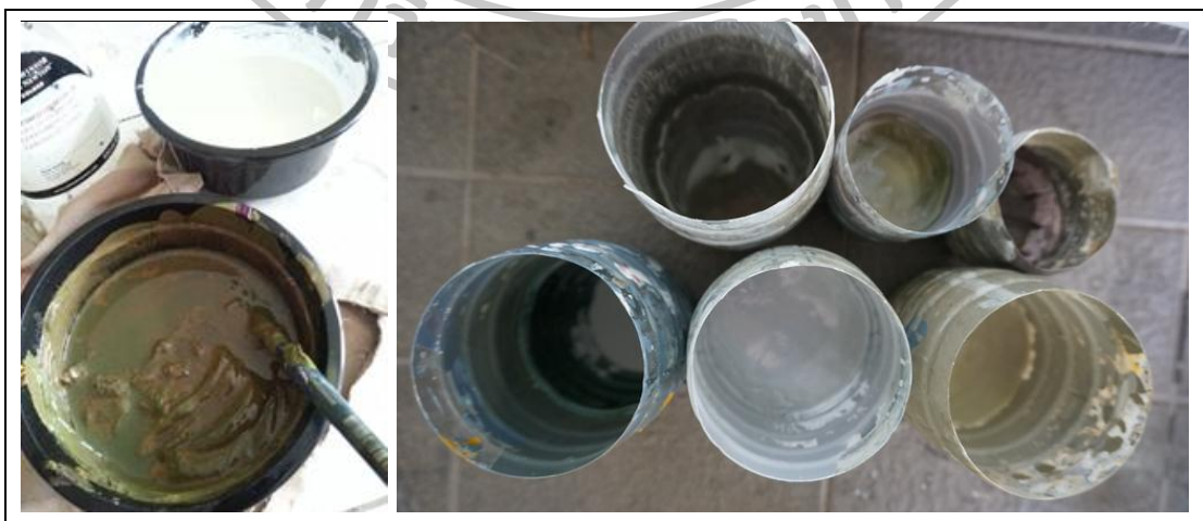
ภาพที่ 57 การผสมสีให้เหลวดีกวจนเข้าเป็นเนื้อเดียว
